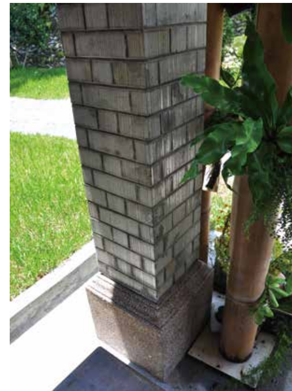
【圖 17】入口門柱 13 溝面磚（2012/07/14）
