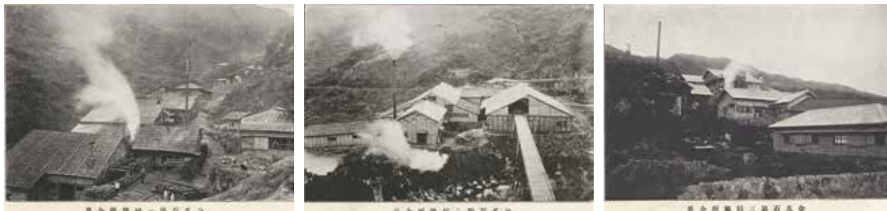
【圖4】由左至右為明治31年、32及33年興建的第一、第二、第三精礦所，使用濕式製煉的混汞法《臺灣金瓜石田中鑛山全景》1903年。
