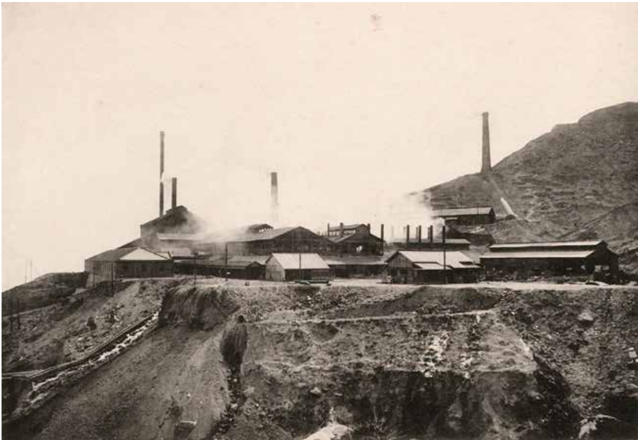
【圖 7】明治 40 年完工的熔礦製煉所，用以處理含金銀銅礦石。《金瓜石鑛山寫真帖》1913 年。
