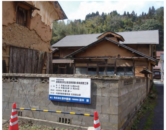
▲指定文化財保存修理の様子
