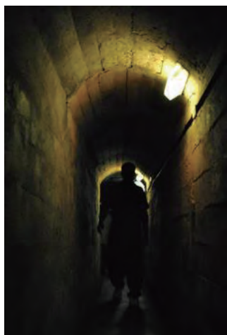
瓊林民防坑道
