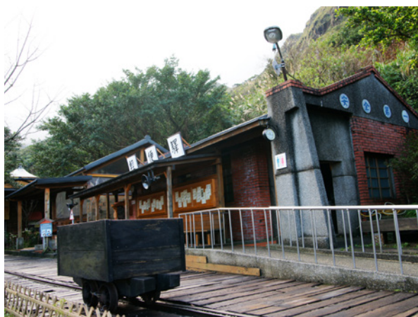
輕便驛旁無障礙廁所
