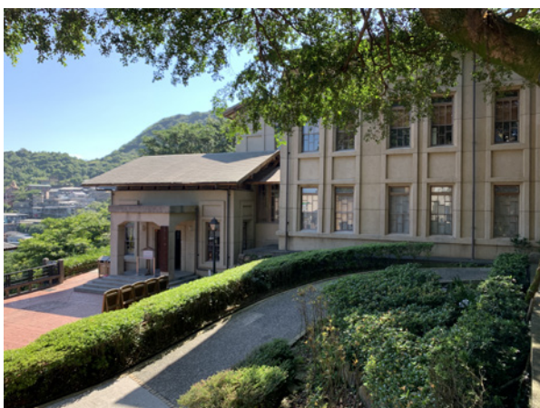
行政辦公室旁S坡道
