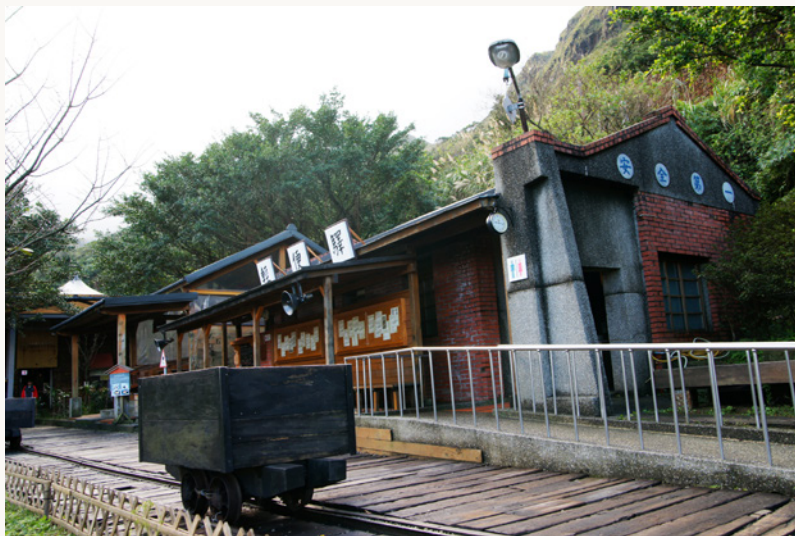
輕便驛旁無障礙廁所
