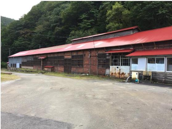
圖 3-10 在大橋分工廠留下的「木骨煉瓦造」的建築物
