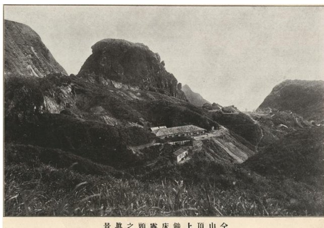
圖 2-13 顯示露頭開發狀況之照片
