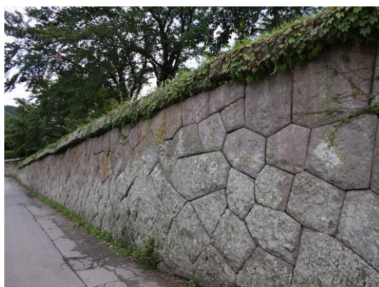
【圖 4】疊石加工示意_切整接+龜甲砌
