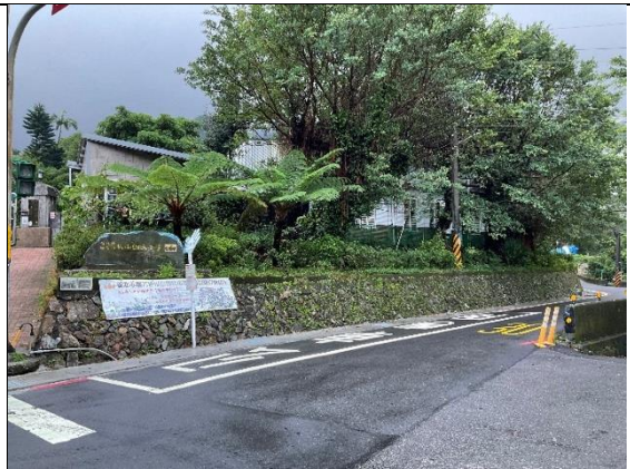
【PF-K01-圖 2】校門口右側圍籬現況-新增濕式砌石牆，樹叢後方可見另一道石砌駁坎
