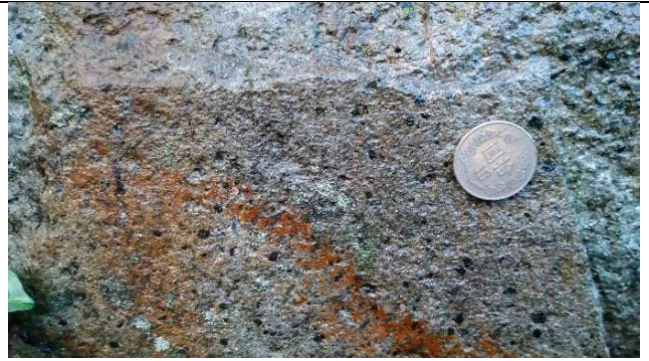
【DH-K05-圖 10】石山里活動中心前方駁坎石材基部顏色及斑晶
