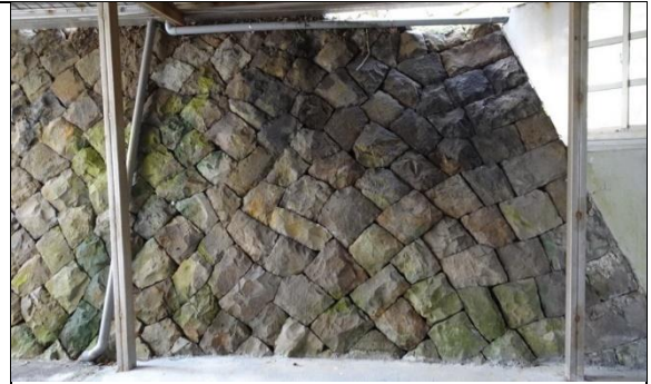
【DH-K01-圖 2】使用切整接斜角砌工法
