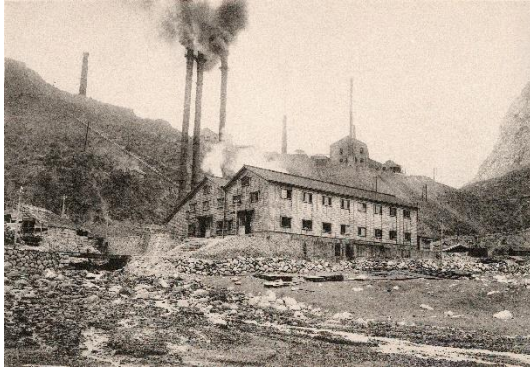
【圖 12】大正初期之水湍洞水力發電所
