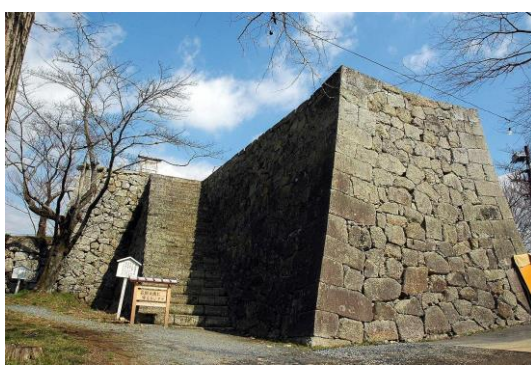
【圖 6】疊石加工示意_切整接+長短疊砌
