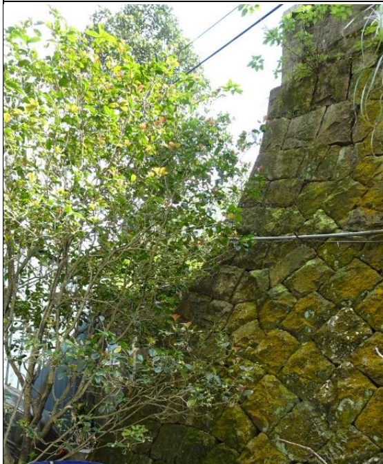
【DH-K01-圖 5】轉角部構造採用長短疊砌，並呈現扇形弧度
