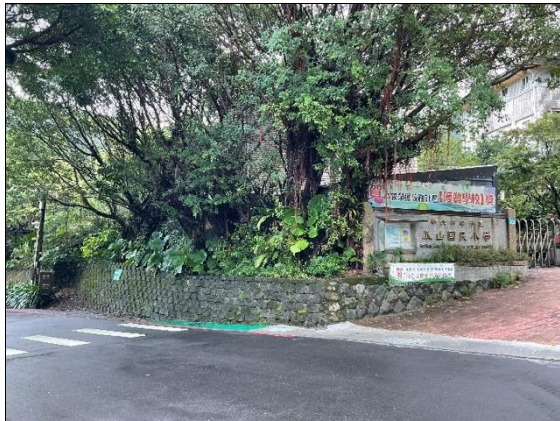
【PF-K01-圖 1】校門口左側圍籬現況-改用混碎石玻璃水泥磚
