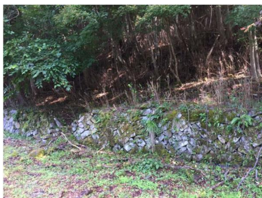
【圖 10】釜石鑛山手推車道駁坎
