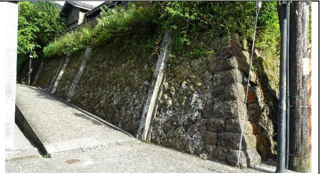
【DH-K04-圖 2】駁坎面加設磚造水泥飾材以包覆落水管
