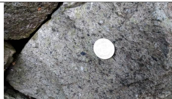
【PF-K01-圖 6】校門右側亂石砌駁坎石材有斑晶，推測為安山岩
