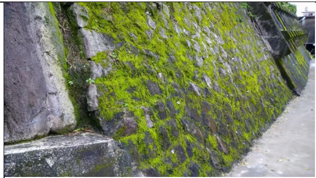
【PF- S01-圖 2】原有駁坎以水泥加固
