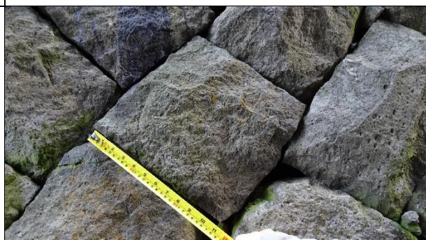
【DH-S01-圖 6】水湳洞職工宿舍駁坎所使用的間知石尺寸約 30 公分見方
