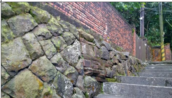
【DH-K03-圖 4】駁坎缺石處以磚塊填補
