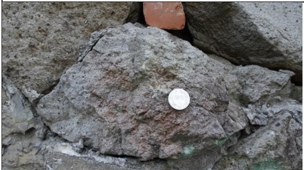
【DH-S02-圖 6】洞頂路 101 巷 7 號屋舍下方駁坎灰色石塊有斑晶
