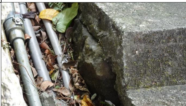
【DH-K03-圖 6】現有水泥階梯下方可見原石板階梯
