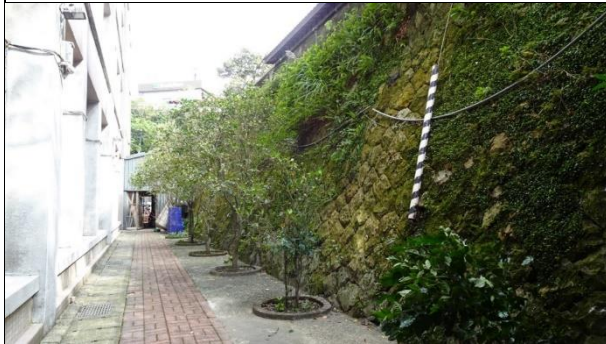
【DH-K01-圖 3】駁坎構造原樣保存完整（位於時雨中學校內），有植物攀附及青苔生長
