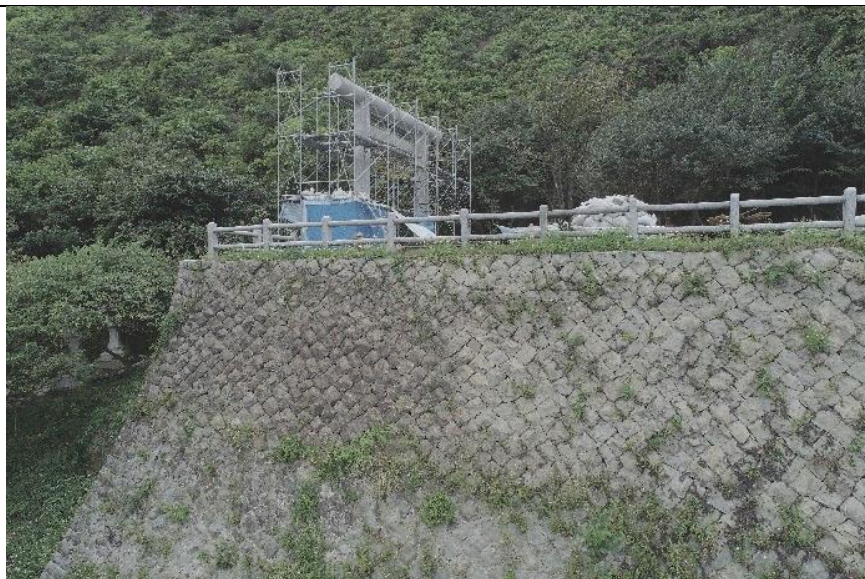
【PF-K02-圖 1】從圖片左下方可明顯看到駁坎下半部塗覆水泥
