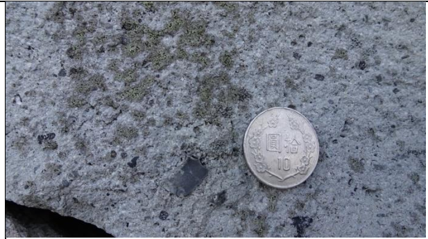
【DH-S02-圖 2】四町目最下層第一棟長屋後院駁坎灰色石材黑色斑晶，初步推測為安山岩
