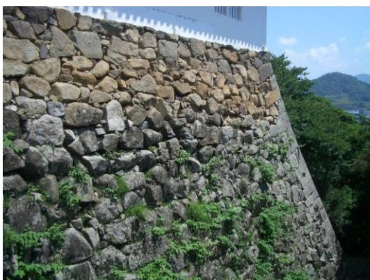
【圖 3】疊石加工示意_天然石砌+亂石砌
