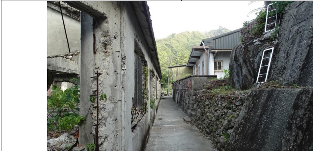
【DH-S02-圖 3】圖左側為五町目最上層 6 戶長屋遺構，右側屋舍（洞頂路 101 巷 7 號）下方駁坎高度約 1.5 公尺，砌法較為凌亂，駁坎上方為磚砌女兒牆，推測為日治後期或戰後整地建構
