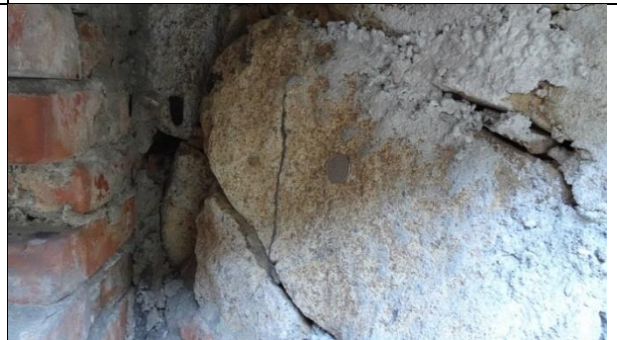
【DH-S02-圖 7】洞頂路 101 巷 7 號屋舍下方駁坎內凹空間內石塊有一塊硬幣大小的黑色斑晶
