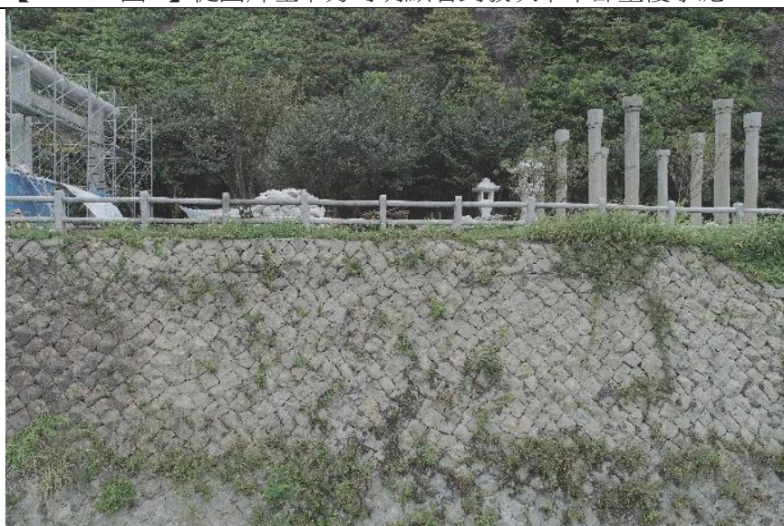
【PF-K02-圖 2】植物根系攀附駁坎表面，右側有部分石材接合面出現縫隙
