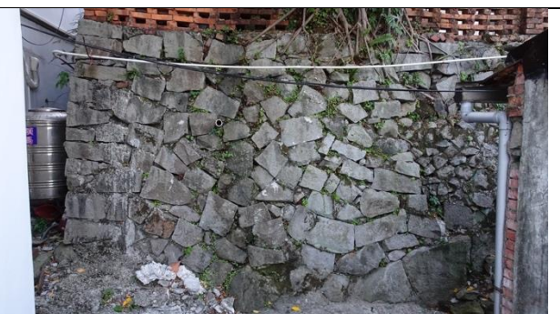
【DH-S02-圖 15】從堆砌咬合、不規則石塊及上方磚砌牆推測此面駁坎為戰後重建（洞頂路 105 號旁）
