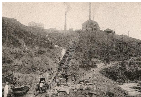
【圖 59】金瓜石田中事務所時期斜坡索道 左側山壁可見砌石工人、索道右側也可看到已加工好的石材（局部放大圖請參照圖 53） 資料來源：絹川健吉（1914）。金瓜石鑛山寫真帖。基隆郡：絹川寫真館
