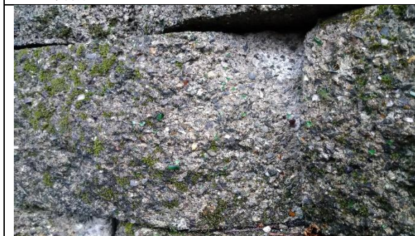
【PF-K01-圖 5】校門口左側圍籬使用的混碎石玻璃水泥磚細部
