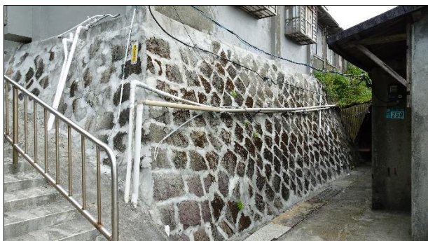
【DH-S01-圖 1】洞頂路 259 號前駁坎縫隙已經填充水泥
