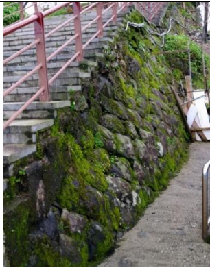
【DH-S01-圖 9】水湳洞職工宿舍 A 區階梯駁坎構造
