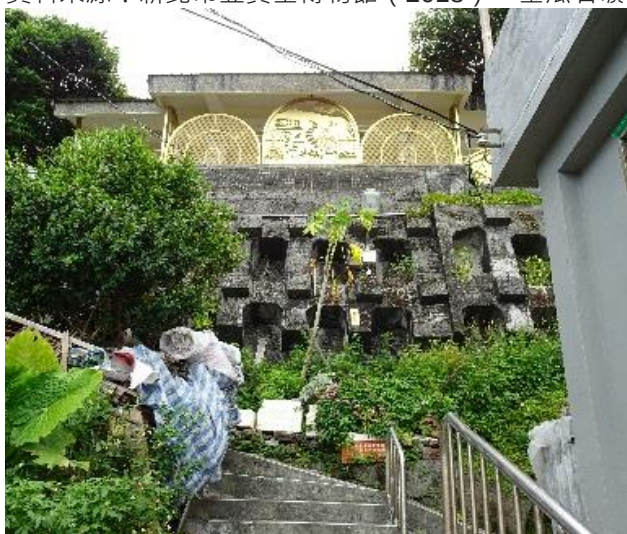
【圖 49】濂洞國小校門口已改建至 101 巷，原校門目前為混凝土擋土牆
