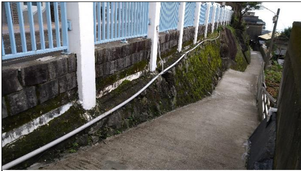
【PF-S01-圖 1】現校門側之濕式砌石駁坎
