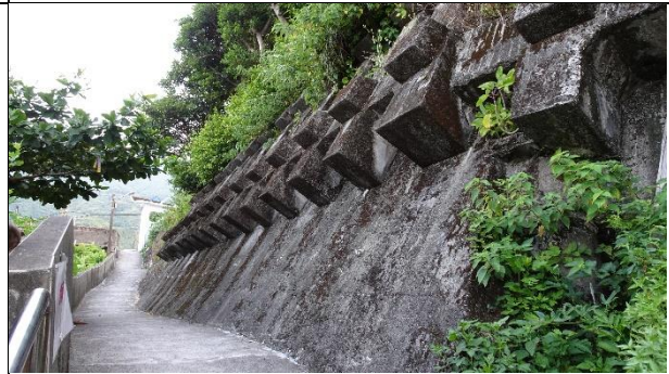
【PF- S01-圖 4】混凝土擋土牆使用地錨加固
