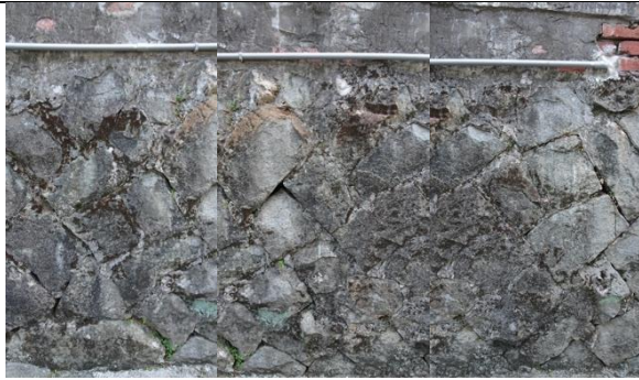
【DH-S02-圖 8】五町目最上層長屋遺構前方駁坎堆砌較為凌亂
