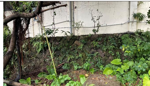
【PF-K01-圖 8】推測本段為原有間知石石砌駁坎
