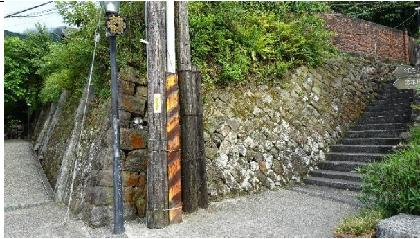
【DH-K04-圖 1】西側轉角有缺石，石材結合面縫隙較大
