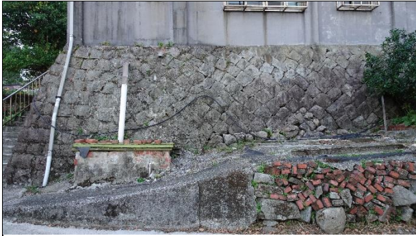
【DH-S02-圖 1】四町目最下層第一棟長屋後院駁坎構造，斜角砌，左側轉角長短疊砌
