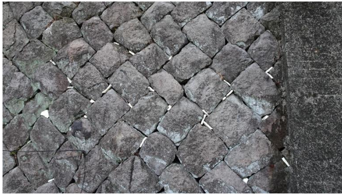
【DH-S01-圖 10】水湳洞職工宿舍 A 區駁坎斜角砌 及保麗龍填充縫隙
