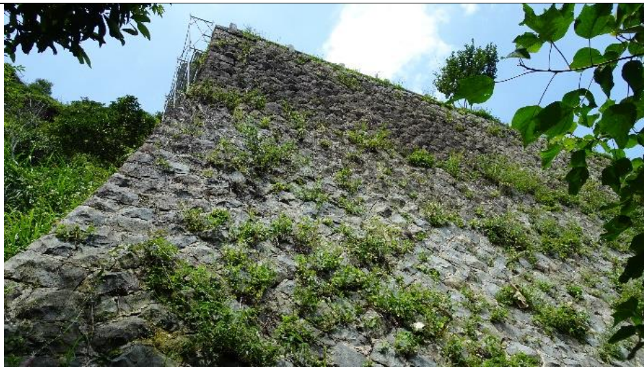
【PF-K02-圖 5】轉角採用長短疊砌並微微朝上彎弧
