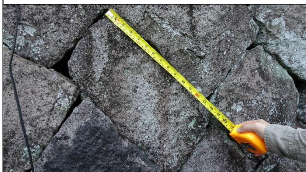
【DH-S01-圖 5】水湳洞職工宿舍駁坎所使用的長形石尺寸約長 35*寬 20 公分
