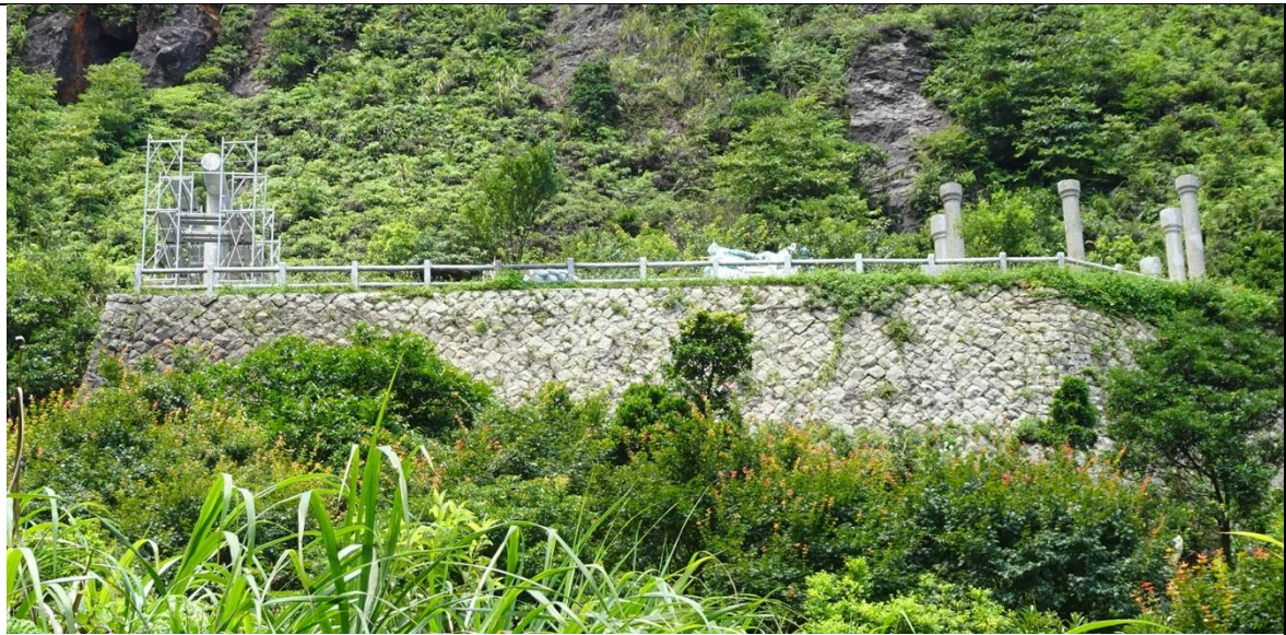
【PF-K02-圖 4】駁坎右側轉角處採用平石砌工法
