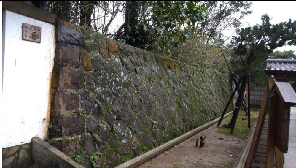
【DH-K02-圖 4】金瓜石外牆駁坎轉角長短疊砌工整，天端石修整平切
