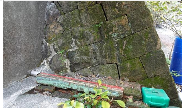
【DH-K01-圖 4】轉角部構造採用長短疊砌，與水泥牆接縫使用水泥填縫
