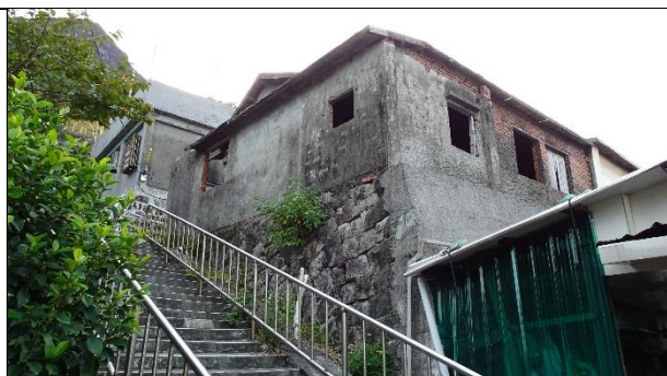
【DH-S01-圖 2】洞頂路 259 號已經改建為磚造水泥建築，下方駁坎整面鋪設水泥
