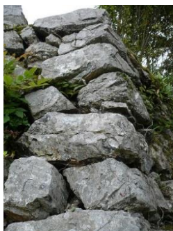
【圖 8】疊石加工示意_敲打接+長短疊砌
